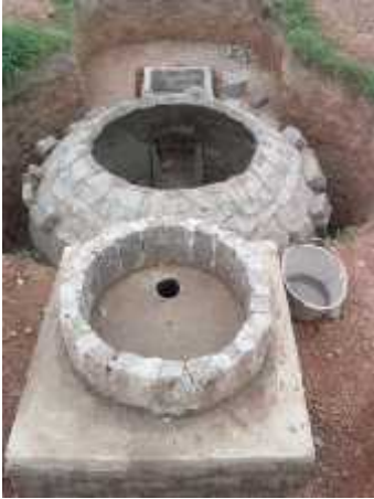
Le bio digesteur en construction
